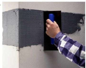
3) Lepení začínáme vždy rohovými pásky ( 360mm ). Ty po nahřátí horkovzdušnou pistolí se dají snadno ohýbat, bez popraskání.
