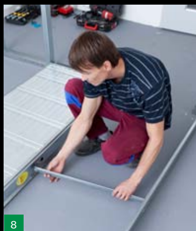
8 Ohnuté distanční vzpěry zasunout do prolisů
