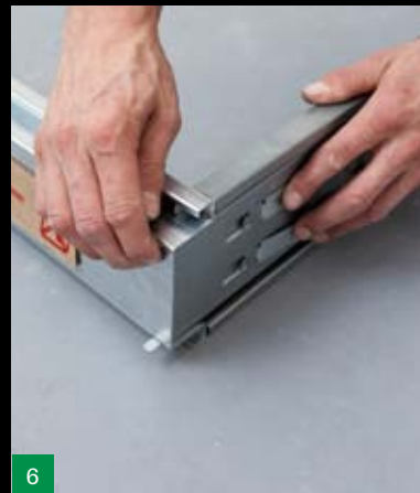
6 Ohněte jazyčky stojiny, aby došlo k zajištění
