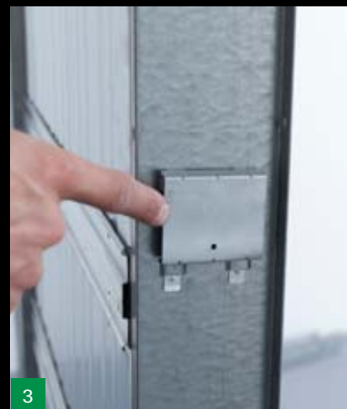
3 Kotevní místo pro SDK profil stavebního pouzdra
