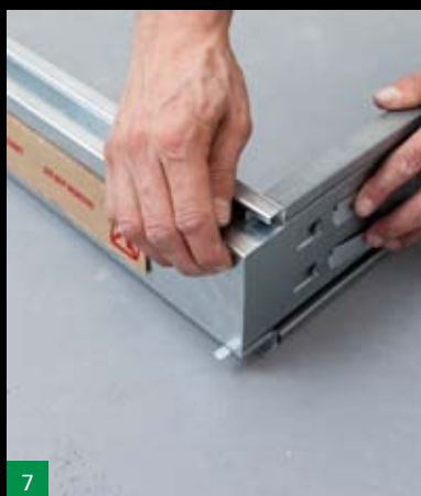
7 Ohněte jazýčky stojiny, aby došlo k zajištění
