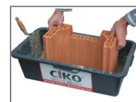
Namáčení tvarovky do lepidla
