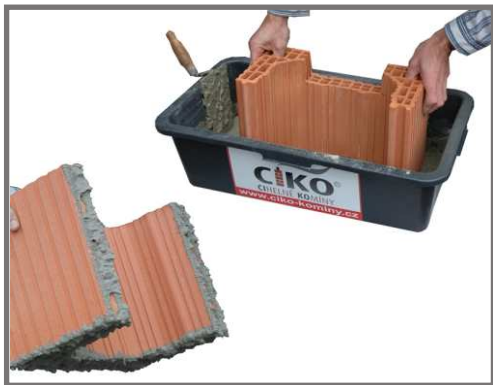
obr. 1 Namáčení cihelných tvarovek
